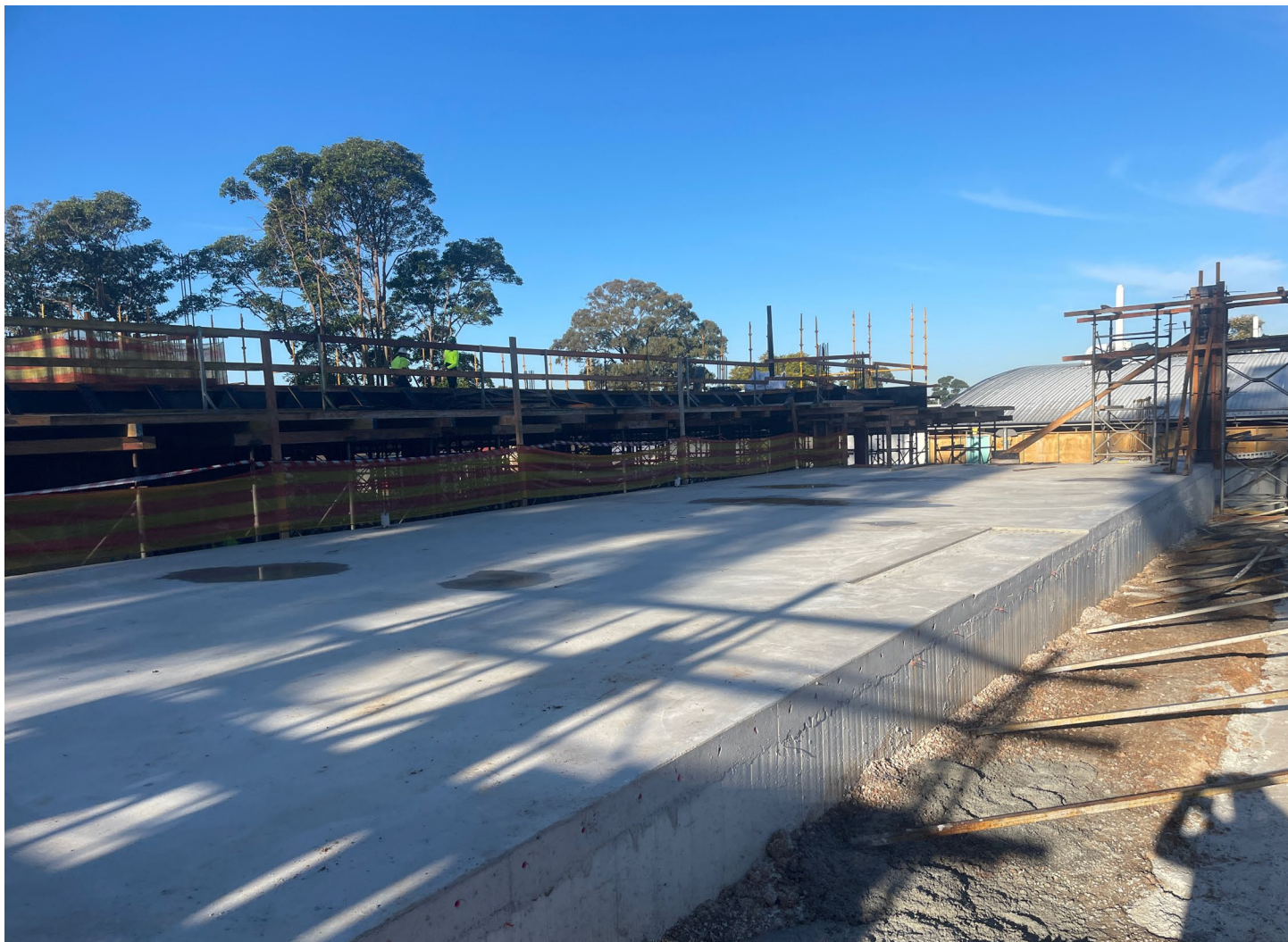
Progress photo of foundation concrete pour
