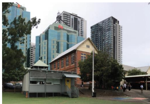
Chatswood CBD + 'Building A' Heritage item
